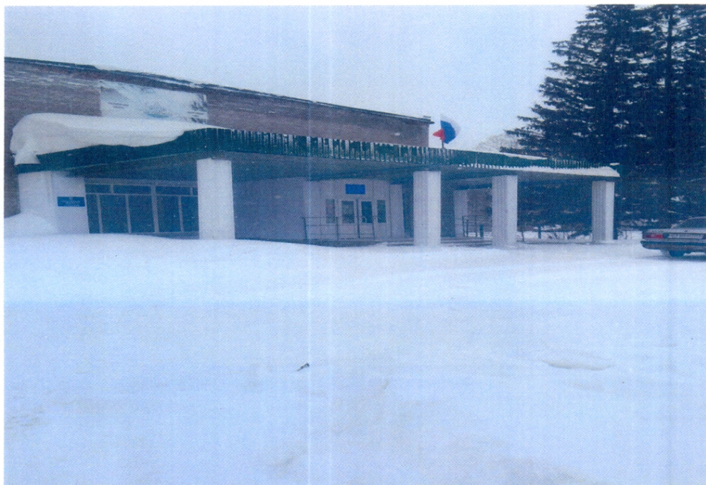
Фото 1: Территория, прилегающая к зданию
