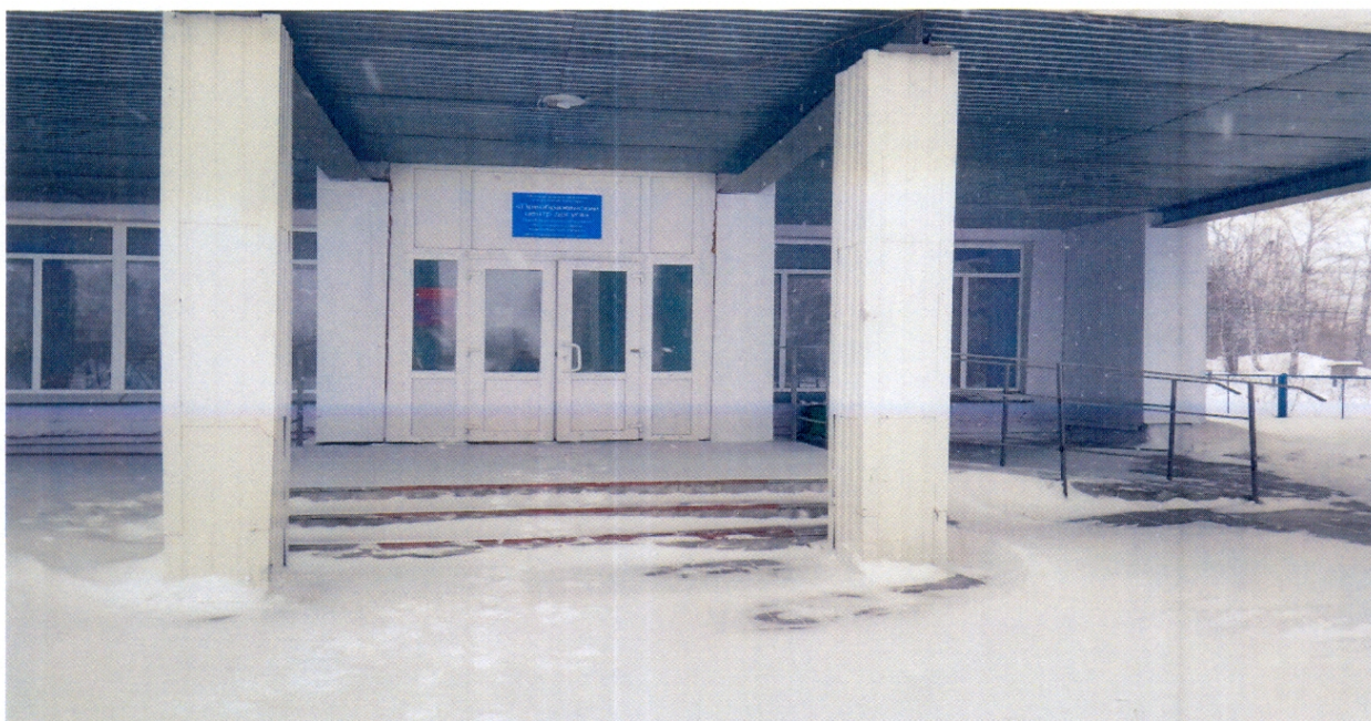
Фото 2: Вход в здание
